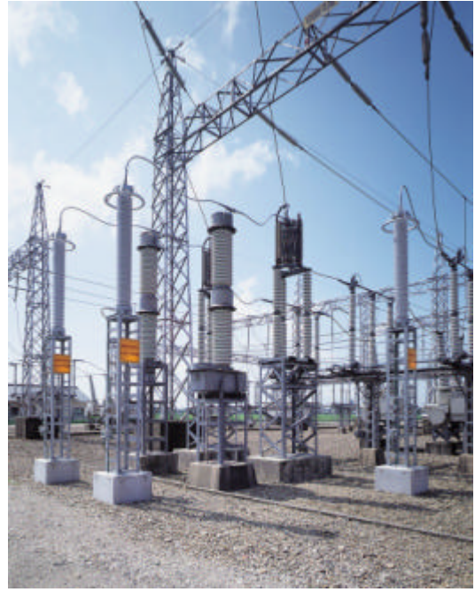
明電舎 154kV 系統用ポリマー形アレスタ (東北電力様 三条変電所納入)
